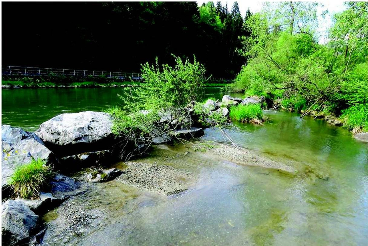
Abbildung 12 : Blockwurf am Eingang des Seitenarmes
